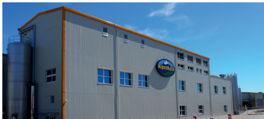
Alpenhain hat den Standort Lehen 2020 um einen Neubau erweitert (foto: mi)
